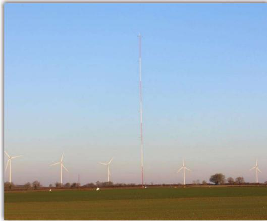
Figure 8 : Mât de mesures anémométriques du projet de la plaine de Balusson (Crédit photo : EOLISE)
